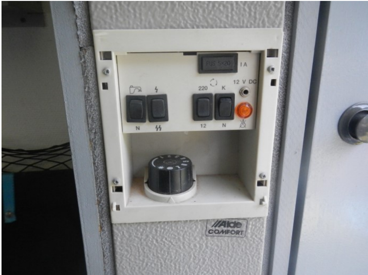
Alde-Warmwasserheizung Bedienfeld ,
